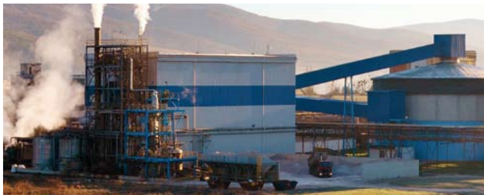
Výrobná LV GG v Strážskom. V strede dole sklad kusového vápenca, vľavo rozkladný reaktor, neutralizátor a odparky, filter a suchá časť sú vo vnútri budovy, vpravo sklad LV GG, vzadu v strede balička.
