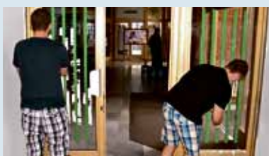
Oškrabávanie náterov na vstupných dverách Centra zdravotnej starostlivosti
